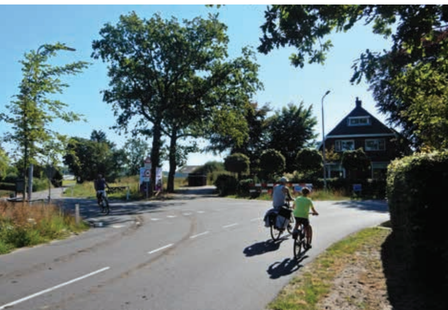
Fietzers op de Margrietenlaan die linksaf willen slaan naar de Nieuweweg, hebben slecht zicht op het verkeer dat van rechts van de 1e Loosterweg komt (veel gebruikt door auto-verkeer). Een spiegel zou uitkomst bieden.
