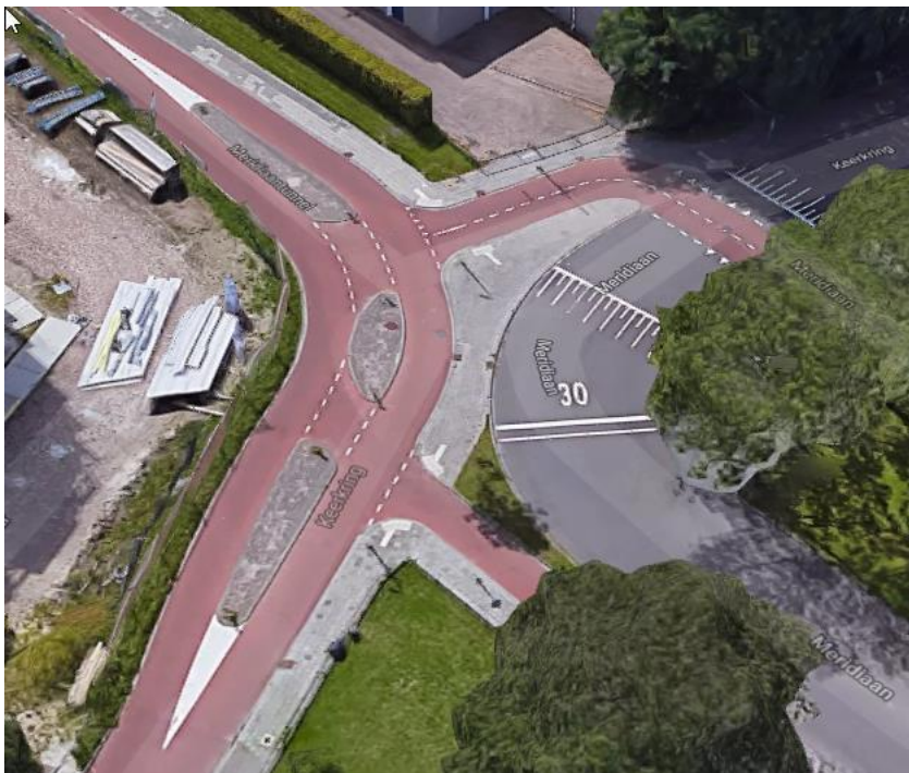
Figuur 3 Meridiaantunnel – Keerkring
