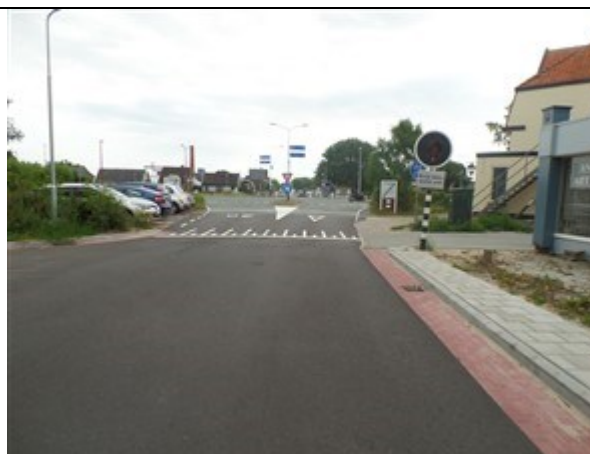
Foto 6 Vóór de N9 staan links en rechts van de Zeeweg deze borden A02-030. Ze zijn in slechte staat en links wordt het te laag geplaatste bord afgedekt door geparkeerde auto's.
