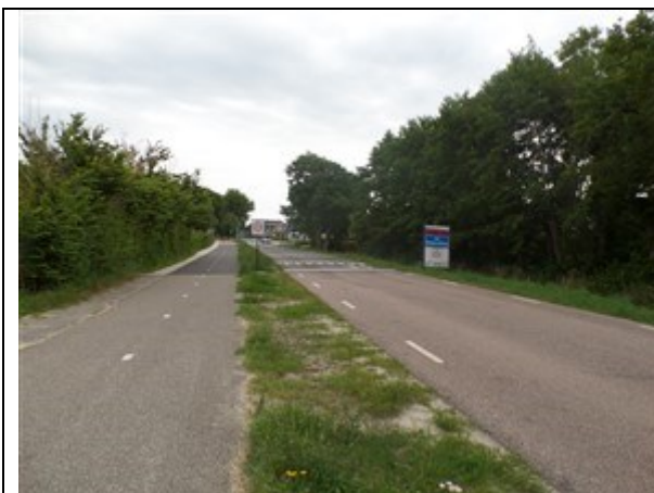
Foto 5 Komend vanaf Sint Maartenszee staat aan het begin van de gerenoveerde Zeeweg dit kombord
