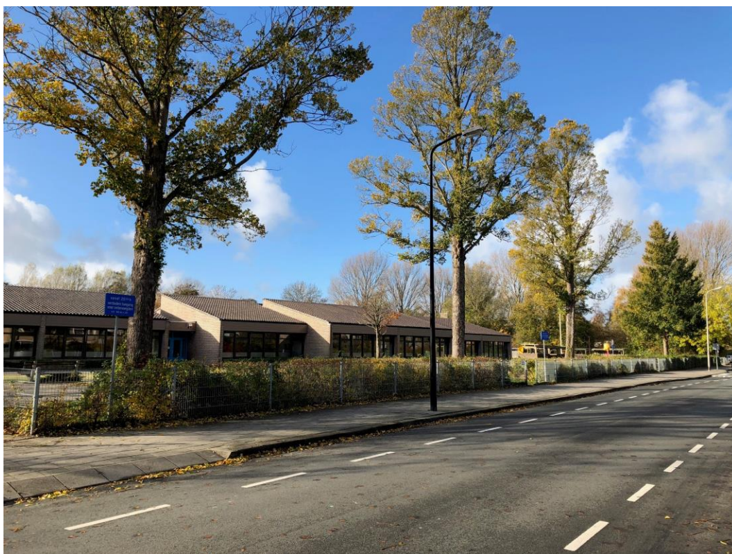
Afbeelding 2.2: Bestaande situatie plangebied, zicht op het schoolgebouw gezien vanaf de Kievitlaan (bron: foto KuiperCompagnons).
