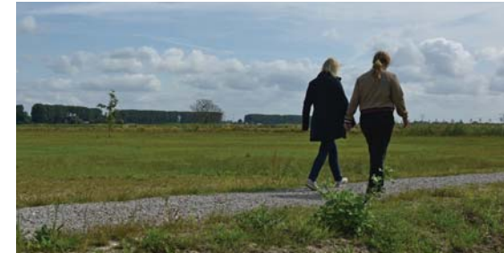
puin verhard pad
