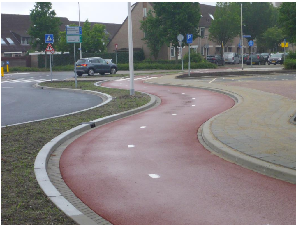
Het opgeknapt fietspad tussen Burg. Bakkerlaan en Staionsplein.
