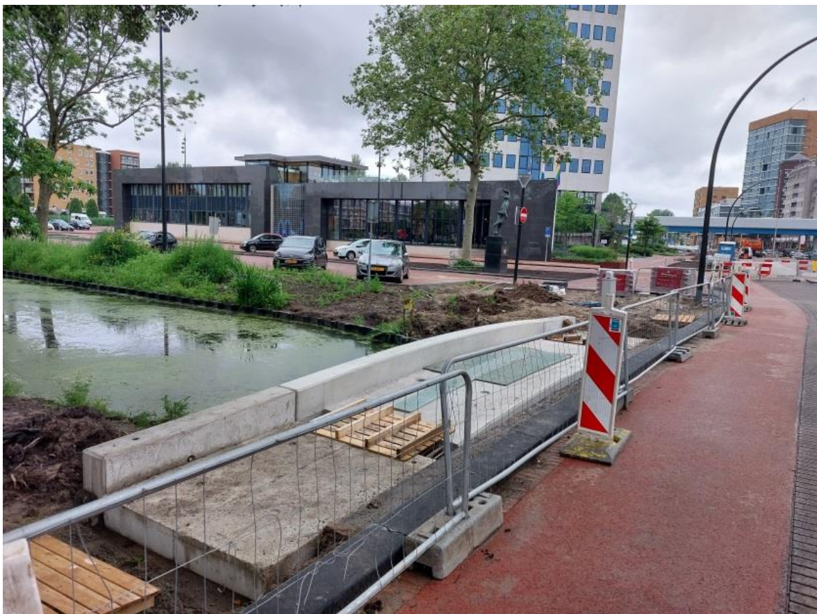
Het nieuwe brugdeel voor voetgangers in aanleg.
