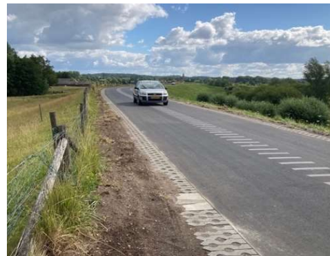
Fig. 5: Proefvak 2 met geribbelde rijloper
