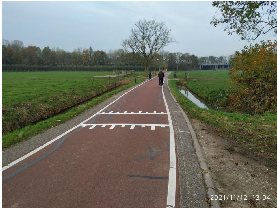
Foto 6a) (jk-UFO) Referentie beeld (smalle) fietsstraat Houten - Utrecht v.v.) met doorgetrokken kantmarkering op de rode asfalt- rijloper = 1) visuele wegversmalling , t.b.v.gewenste Snelheidsreductie van het drukke gemotoriseerde verkeer en 2) t.b.v. Verkeersveiligheid , bij slecht zicht, schemering- en nachtperiode.
