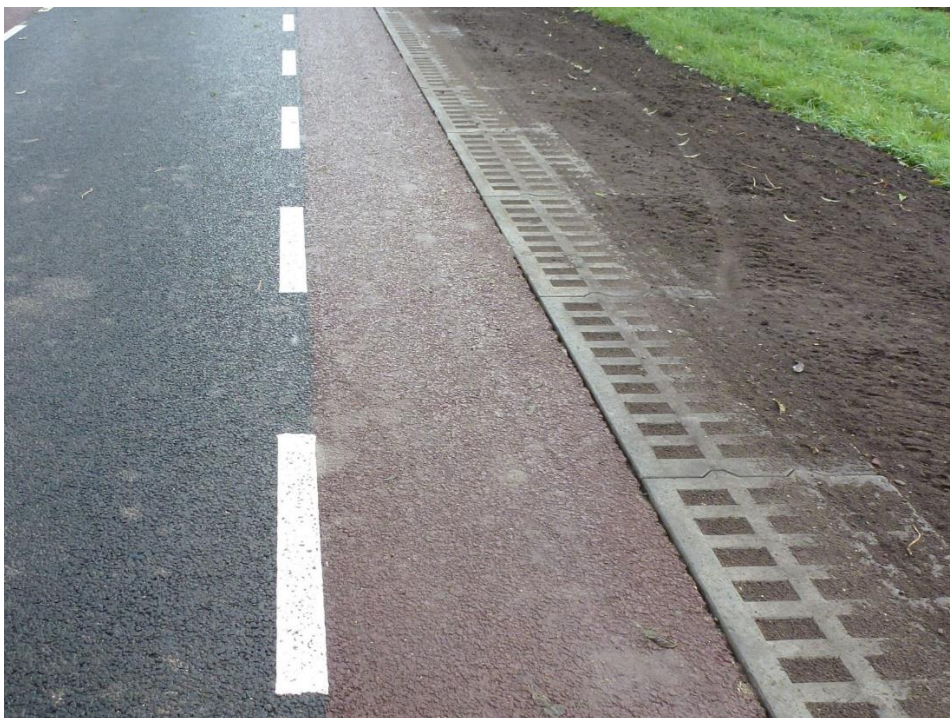
Foto 5) (jk-UFO) Referentiebeeld (Parallelweg Bunnik) met ('vergevingsgezinde') bermverharding, fietsvriendelijke grasbetontegels (= fietsveilig overrijdbaar )
