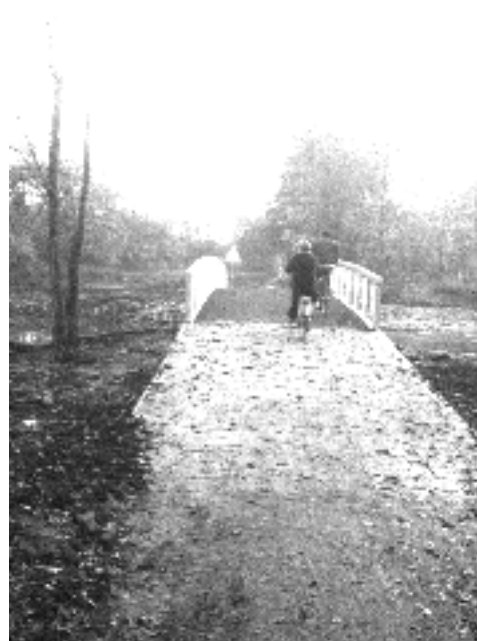
Nieuwe brug over fietspad langs Dommel
