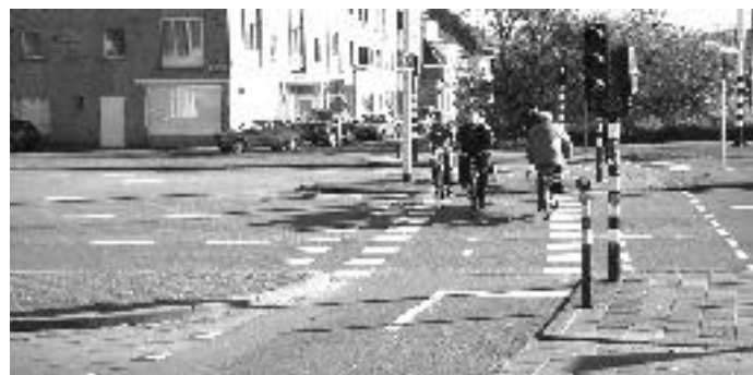
Foute oversteek hoek Oostende en de Torenstraat
