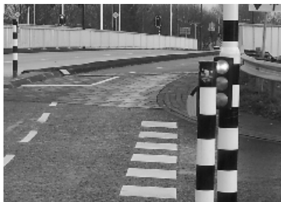
Lastig dat laatste stukje helling over het viaduct
