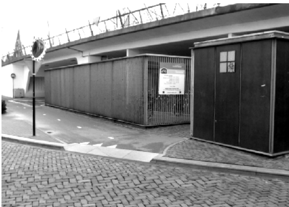
Fietspad stijf langs de entree van de fietsenstalling
