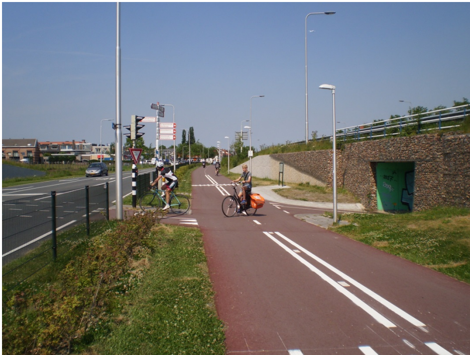
Nieuw fietspad nabij tunnel Slaperdijk Santpoort-Noord
