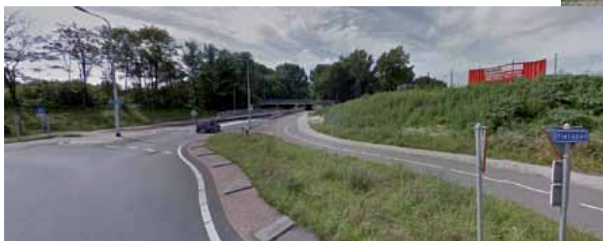
Zeestraat in Beverwijk, rechts op de foto een fietspad uitsluitend voor fietsers, links een fietspad voor al het langzaam verkeer (brommers, snorscooters, fietsers).
