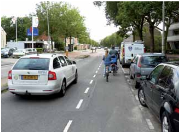
Voorstel van Rover en Fietsersbond voor de Bernadottelaan: Draai de fietsstrook en de parkeerstrook om.
