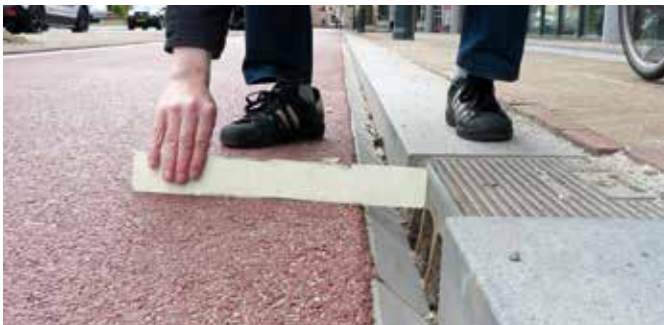
Niet zo: Kennemerplein bij ingang van station: 5 cm diepe gleuf tussen fietspad en trottoir met rechte natuurstenen band.
