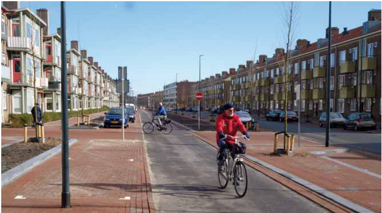
De fietsstraat in de Lange Nieuw 'in het nieuw' (links). De rode top laag is nog niet aanwezig. Rechts ligt de weg voor auto's en ander gemotoriseerd vervoer. Daarnaast, naast de geparkeerde auto's, ligt een vrijliggend fietspad.
