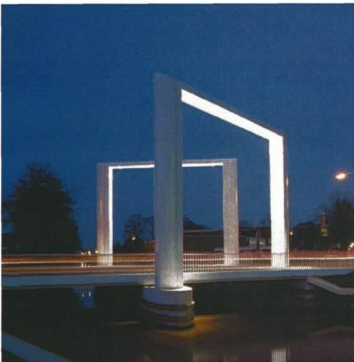
ruimtelijk bescheiden ingepast zoals de Dolderbrug in Steenwijk en de Jullianabrug in Zaandijk
