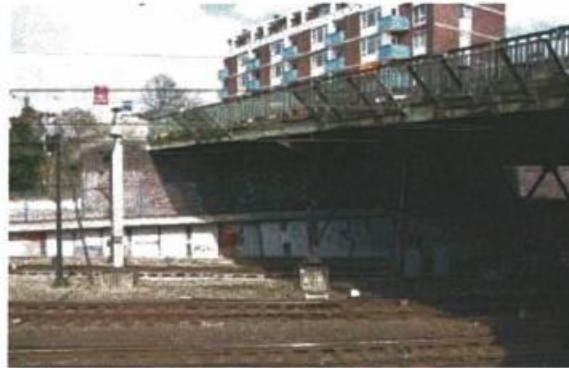
viaduct over het spoor
