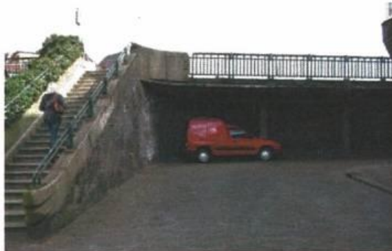
een natuurstenen trap naar het viaduct met een uitkraging
