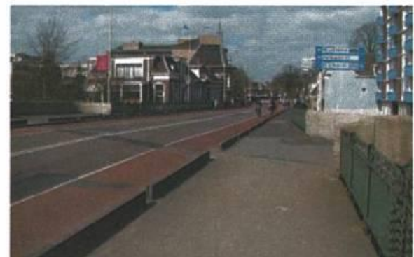
op het viaduct
