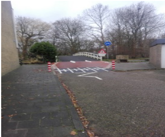
Verbeteringen bij de Giessenbrug in Landsmeer
