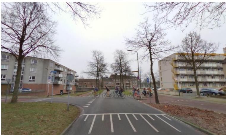
Figuur 2: Fietsoversteek over gebiedsontsluitingsweg (Amersfoort, foto Cyclomedia)
