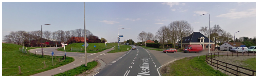
Figuur 3.4: Zicht vanaf N239 op kruispunt, komende vanuit het westen.
