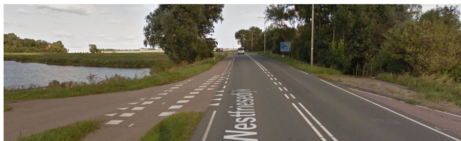
Figuur 3.8: Brug over de Ringsloot gezien vanuit westelijke richting.
