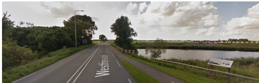
Figuur 3.7: Brug over de Ringsloot gezien vanuit oostelijke richting.
