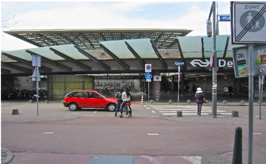
Tweerichtingen fietsoversteek uit de voorrang Waldorpstraat/fietstunnel (spiegelbeeld van Stationsplein/tunneltracé); auto moet voorrang verlenen aan voetganger en blokkeert de fietsoversteek; voorstel Fb: fiets in de voorrang
