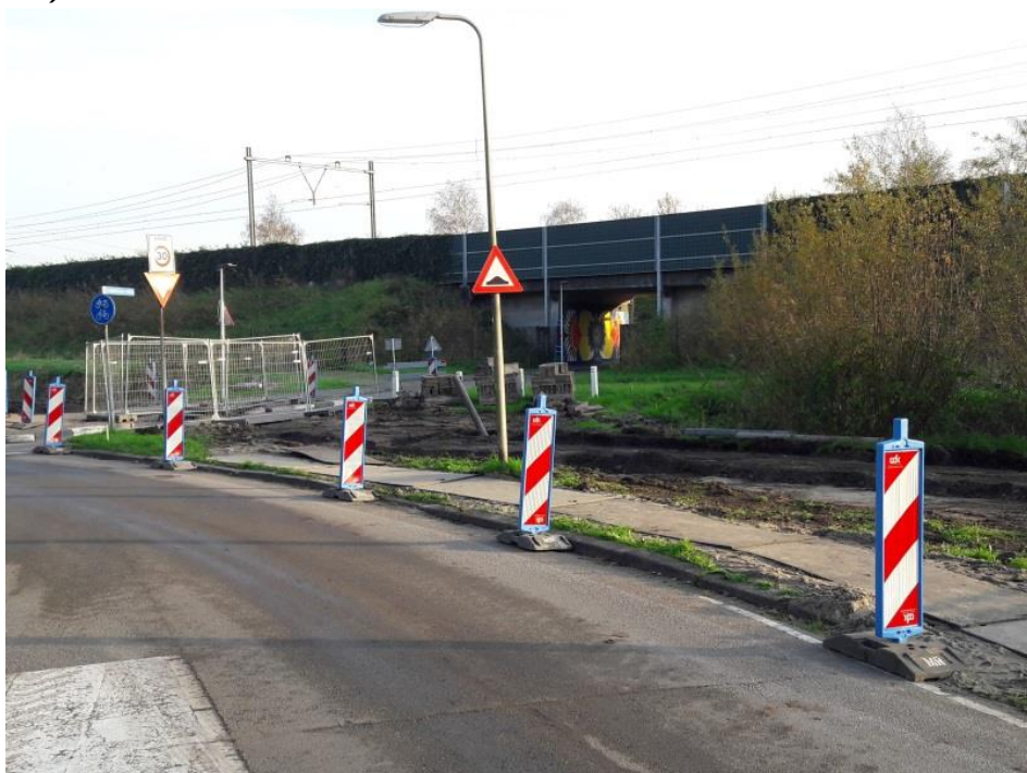
Werkzaamheden ter voorbereiding van het nieuw aan te leggen fietspad langs de Burgemeester Schalijlaan.
