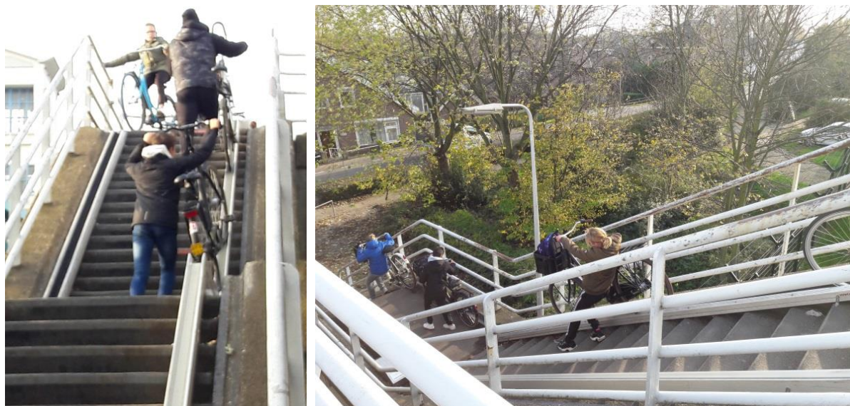
Foto's boven: Het nieuw aangelegde VeloComfortsysteem aan de Krimpense kant van de Algerabrug.
